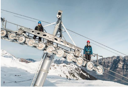
Wartung von Seilbahnanlagen in luftiger Höhe
