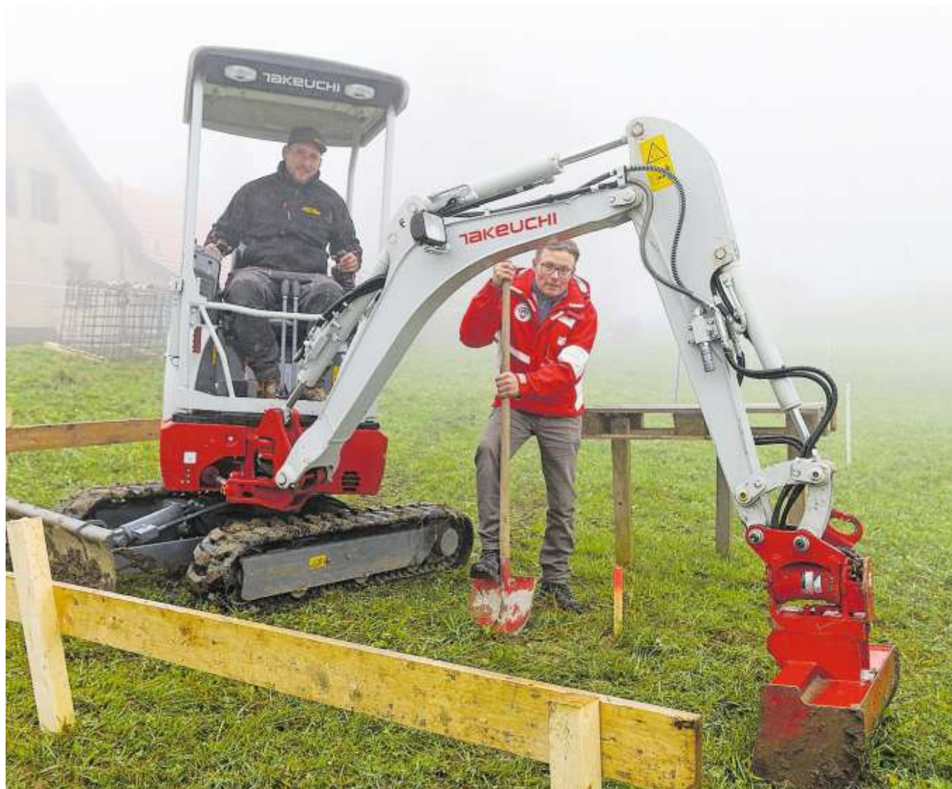
Johannes Solenthaler und Bauunternehmer Michael Fehr beim Spatenstich für den neuen Kleinskillift am Bischofsberg. Bild: Rudolf Hirtl
